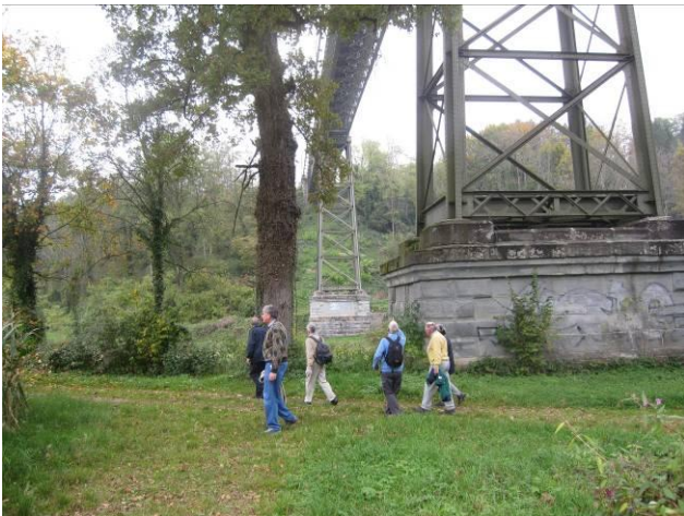
Die Brücke auf Schmiedeeisen-Pfeilern (1875) als bauliches Meisterwerk
